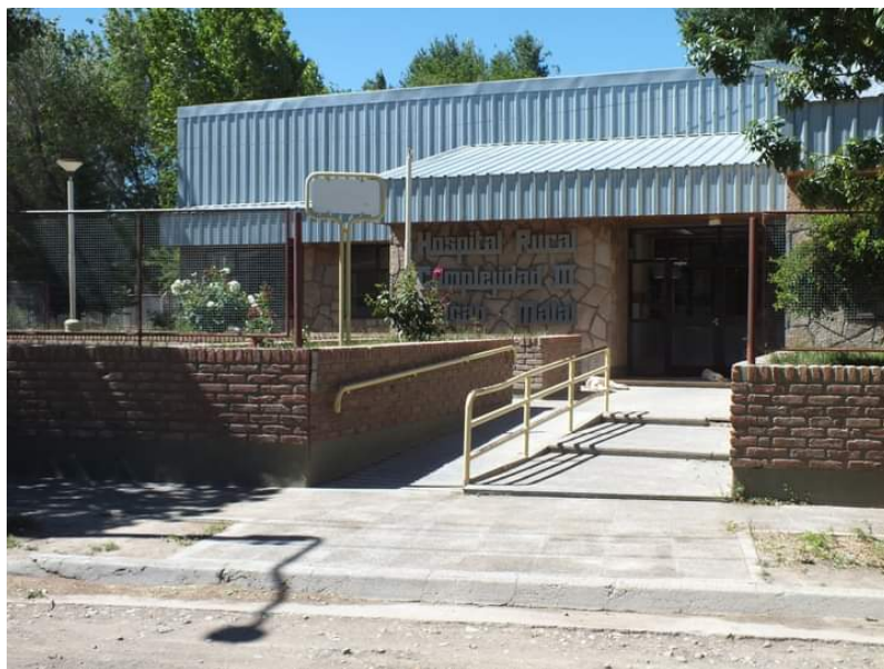
NUEVO HOSPITAL 1991 TRICAO MALAL (su Segundo Hospital)
