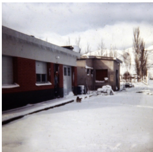
Primer Hospital Tricao casi INAGURADO EN ABRIL 1971 Pegado a la Casa del Medico
